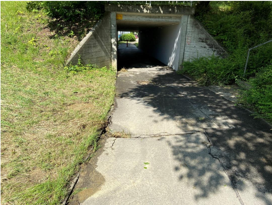
Gehweg Durchlass Bachlangen
