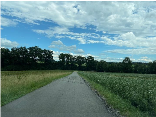
Verbindungsweg – ausgesp. Bankette
