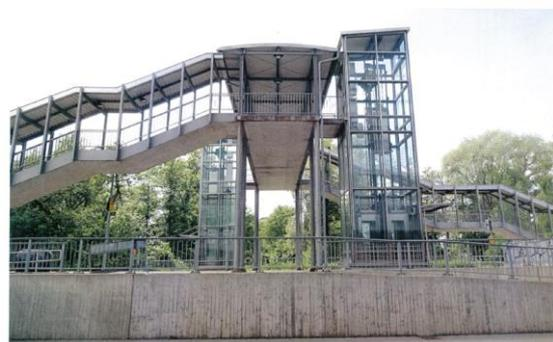
Im Jahr 2017 traten massivere Korrosionsschäden an der Fußgängerüberführung auf, weshalb die Verwaltung ein Bauwerksgutachten in Auftrag gab. Ergebnis des Gutachtens war, dass aufgrund der massiven Schäden, die größtenteils auf Ausführungsfehler zurückzuführen sind, eine längerfristige Nutzung nicht mehr möglich ist.
