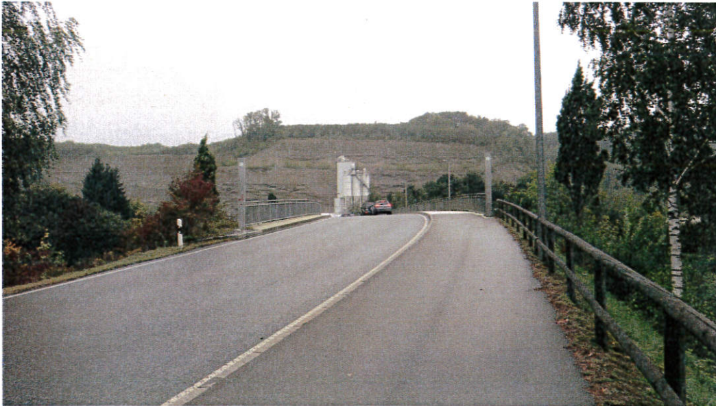
Brücke Freiburger Straße über die Bahnlinie Reno Leuchte links und rechts am Brückengeländer
