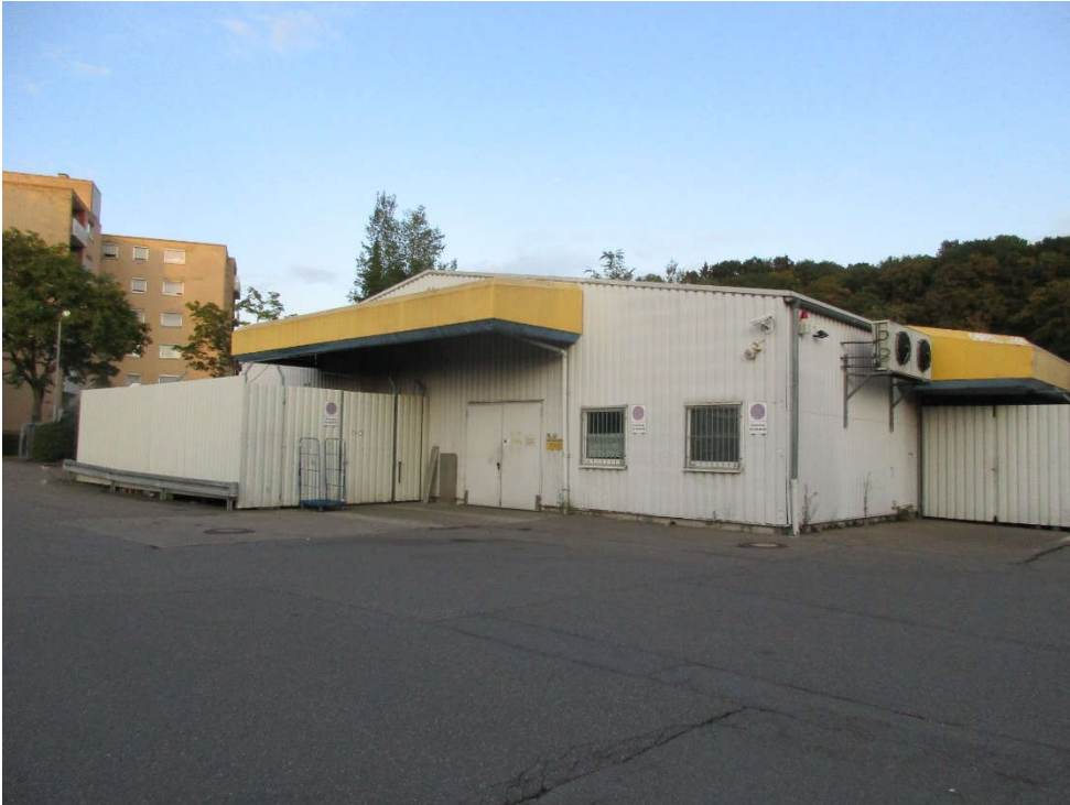
Abbildung 4: Edeka markt, nördlicher Gebäudeteil
