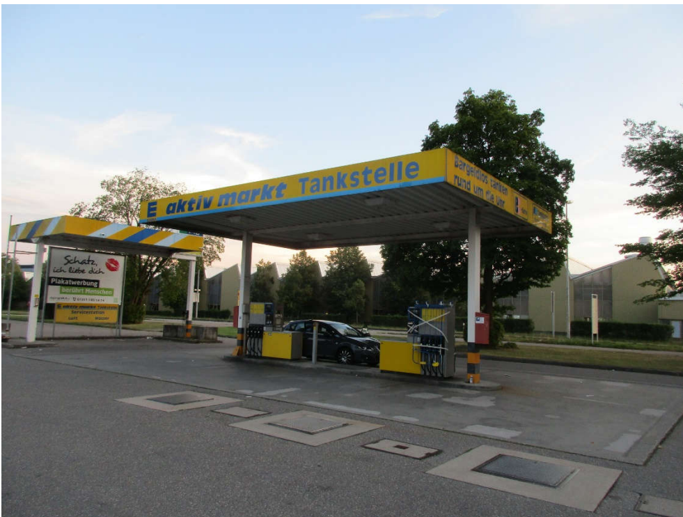
Abbildung 5: Tanksäulen, nordwestlicher Planbereich
