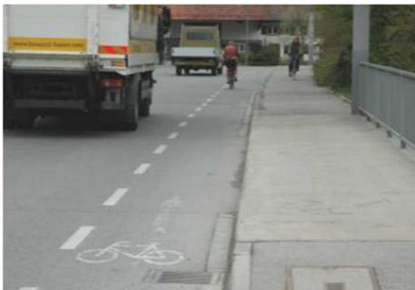
Der Schutzstreifen ist Teil der Fahrbahn. Er darf von Kfz nur im Bedarfsfall (z.B. Begegnung mit Lkw) befahren werden. Schutzstreifen sollen daher bei hohem Schwerverkehrsaufkommen (> 1000 SV-Fahrzeuge/Tag) vermieden werden.
