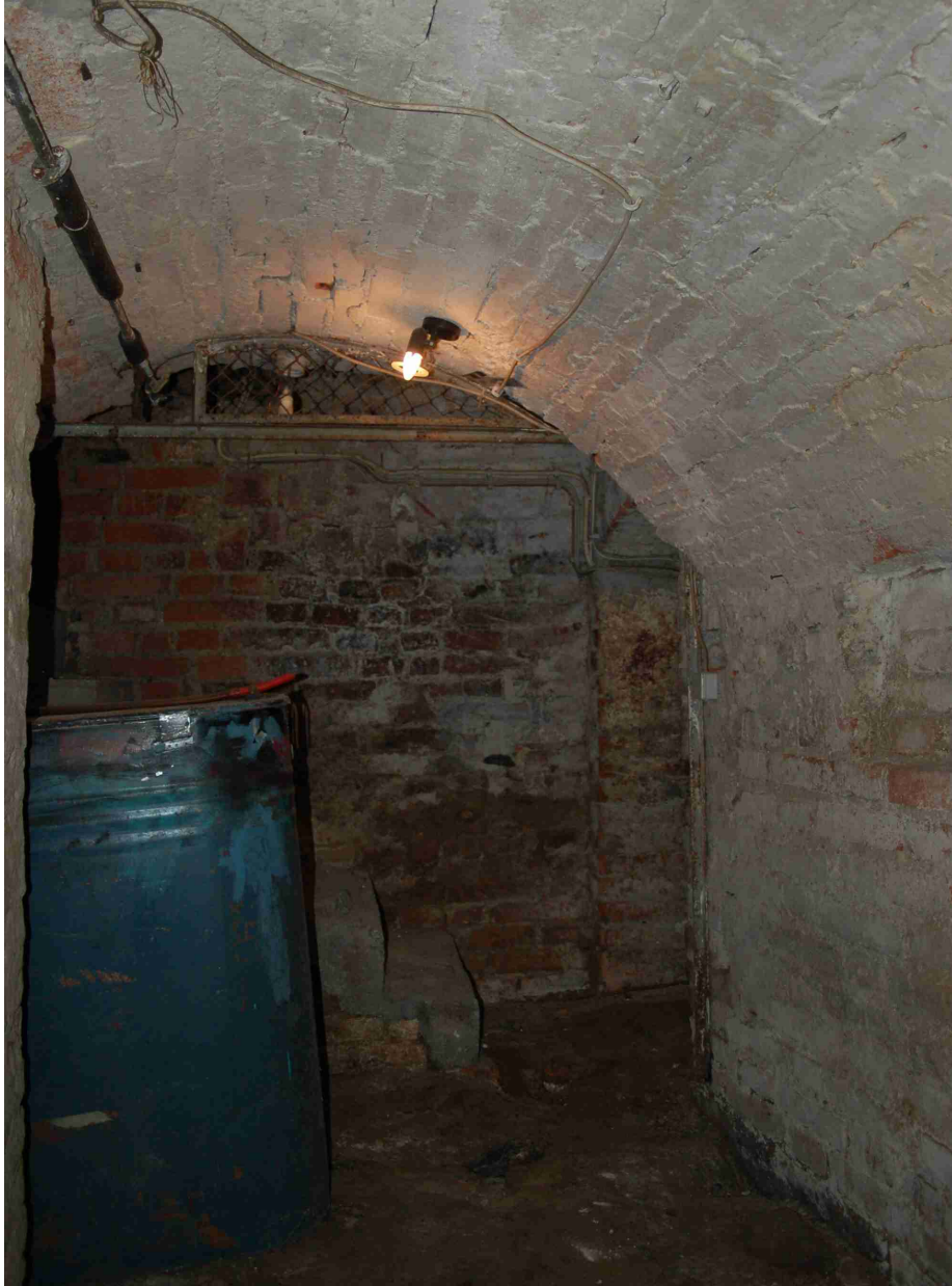
Abb. 7 Kellergeschoß, mittlerer Kellerraum. Der mittlere Kellerraum zeigt eine Einwölbung in Form eines hoch stichbogigen Tonnengewölbes mit deutlichen Schalbrettabdrücken an der Unterseite und wurde erst nach dem südlichen Kellerraum eingewölbt.
