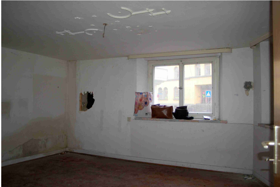
Abb. 10 Erdgeschoß, südlicher Raum (Stube). Blick nach Südosten. Wände modern verkleidet, an der Decke Reste eines geometrischen Deckenstücks wohl aus dem 18. Jahrhundert.
