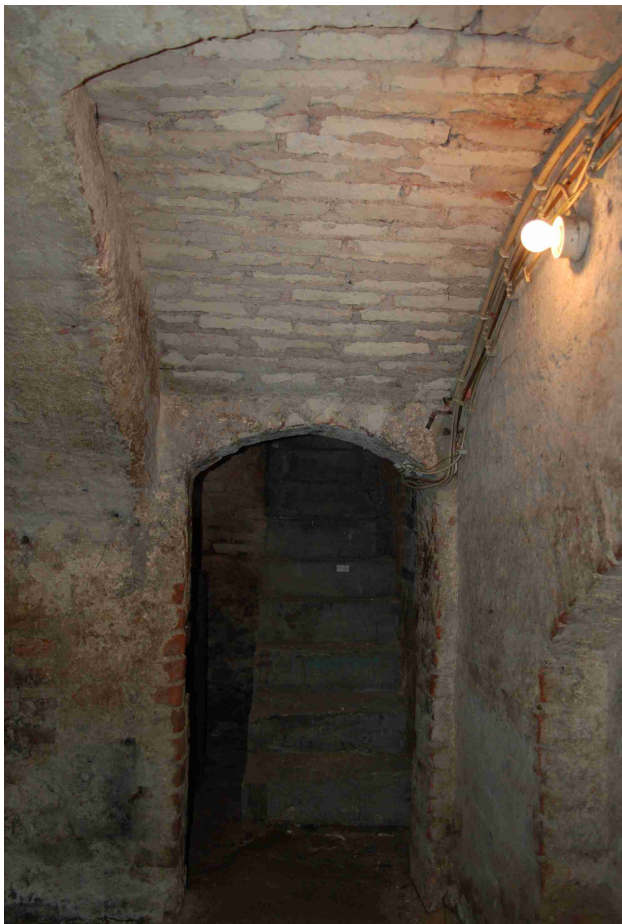
Abb. 6 Kellergeschoß, südlicher Kellerraum. Gewölbeausschnitt in der Nordost-ecke, durch den einst ein Aufgang in das Erdgeschoß heraufgeführt haben wird. Erst später entstand die Verbindungstür zum benachbarten mittleren Kellerraum.
