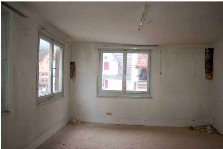
Abb. 22 2. Obergeschoß, nordwestlicher Eckraum. Blick nach Norden. In den Sonden durchweg nachmittelalterliche Fachwerkwandaufbauten.
