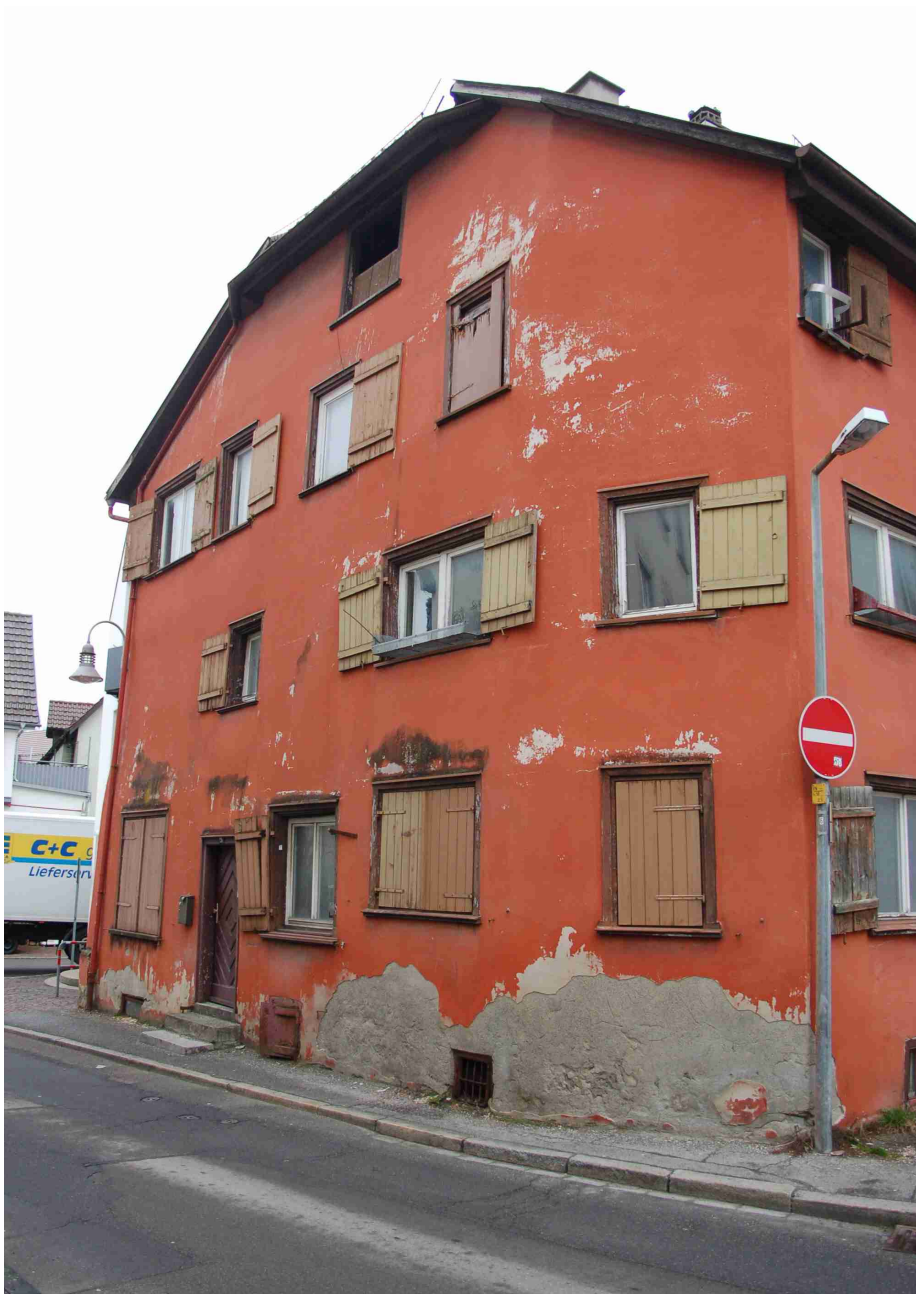
Abb. 2 Blick auf die westliche Giebelseite.
