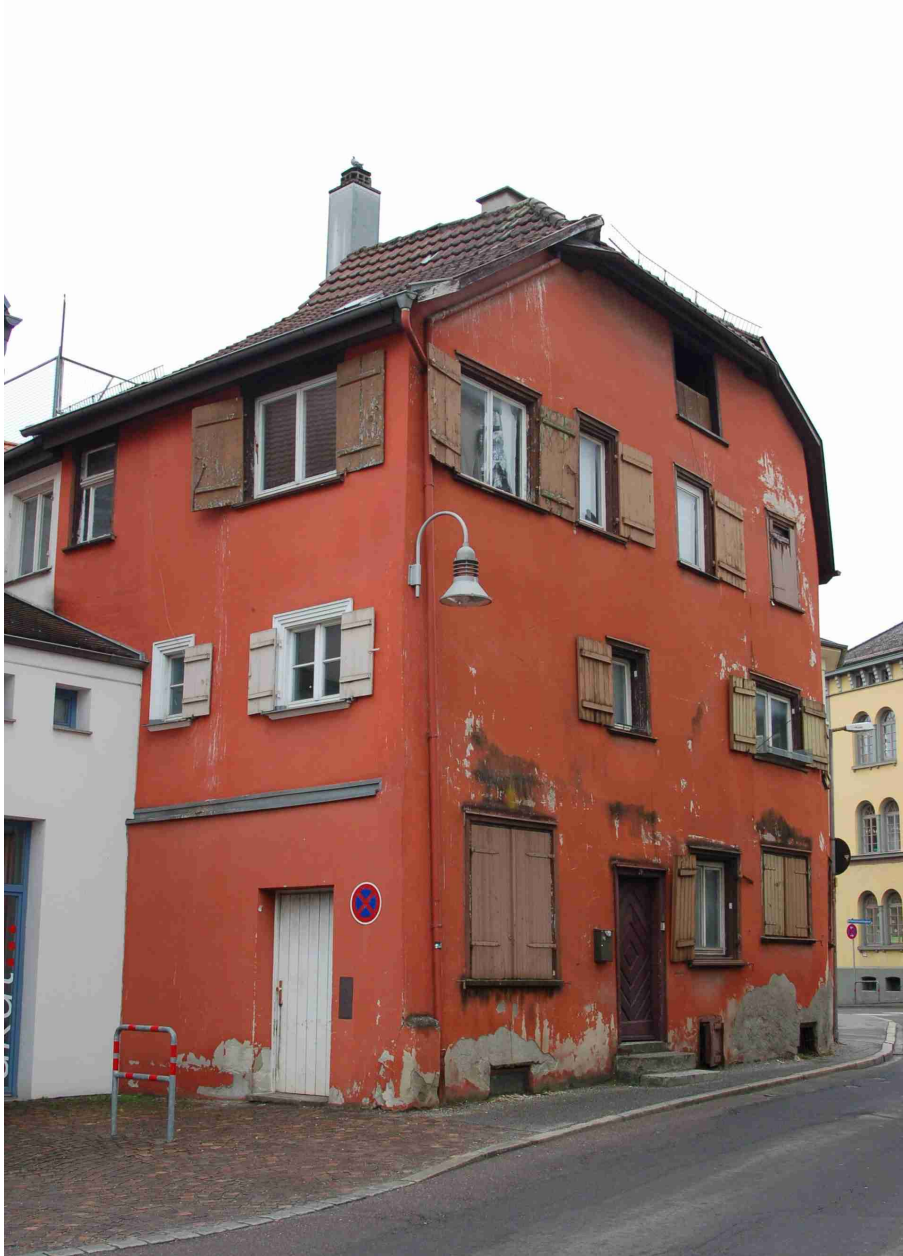
Abb. 1 Gesamtansicht von Nordwesten mit der Nordseite (links) und der westlichen Giebelseite (rechts).
