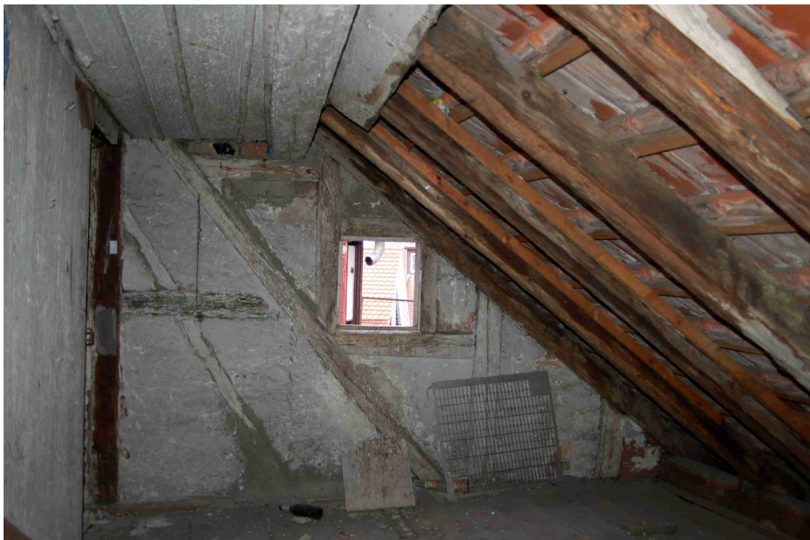
Abb. 26 1. Dachgeschoß, südliche Abseite. Blick auf den südlichsten Abschnitt der westlichen Giebelscheibe mit Abseite und Sparren des 16. Jahrhunderts (links) und der Giebelaufhöhung des 18. Jahrhunderts (rechts).
