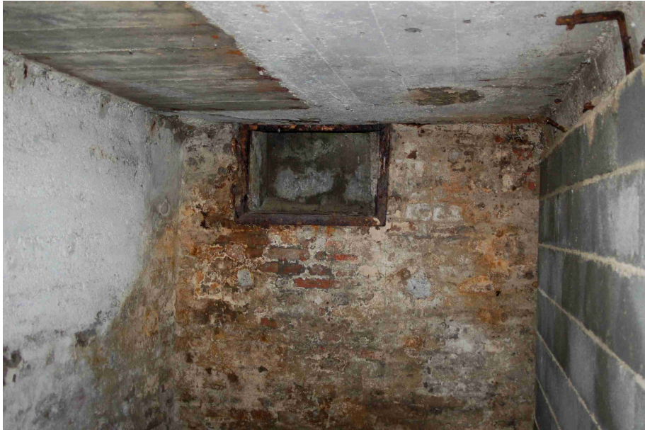
Abb. 8 Kellergeschoß, nördlicher Kellerraum. Blick nach Westen. Nordwand (links) und Decke modern, die anderen Wände in Backstein gemauert.
