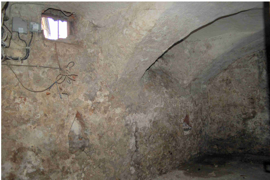
Abb. 4 Kellergeschoß, südlicher Kellerraum. Blick entlang der südlichen Längsseite nach Westen. In der Einwölbung große Stichkappen, die einst mit den zugehörigen Kellerfenstern für eine großzügige Belichtung des Kellerinneren gesorgt haben werden, so daß dieser auch für eine handwerkliche Nutzung (Weberei) dienen konnte.
