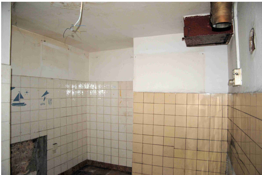
Abb. 11 Erdgeschoß, mittlerer Raum (Küche). Blick nach Nordosten. Nordwand (links) und Ostwand (Mitte) sind Fachwerkwände aus dem 19. Jahrhundert. In der Südwand (rechts) haben sich Reste einer in Backstein gemauerten starken Feuerungswand für einen Stubenofen im benachbarten südlichen Raum erhalten.
