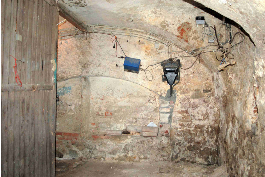
Abb. 5 Kellergeschoß, südlicher Kellerraum. Blick auf die östliche Stirnseite mit stichbogiger Nische im Backsteinmauerwerk.
