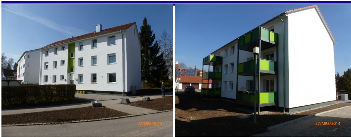
Hans-Rohrer-Straße 17 2013/2014 energetisch saniert
