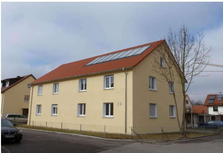
4-Familienhaus Hölderlinstraße 2 und 4 - 2010 energetisch saniert
