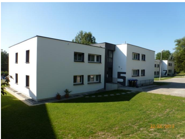
Energetische Sanierung Laurenbühlweg 5 - 7
