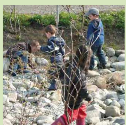
KIES- UND WASSERBAUSTELLE
