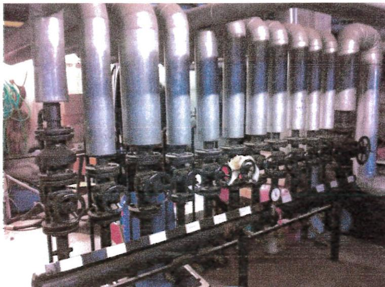
**Abbildung 1-3: Kaltwasserverteiler**
