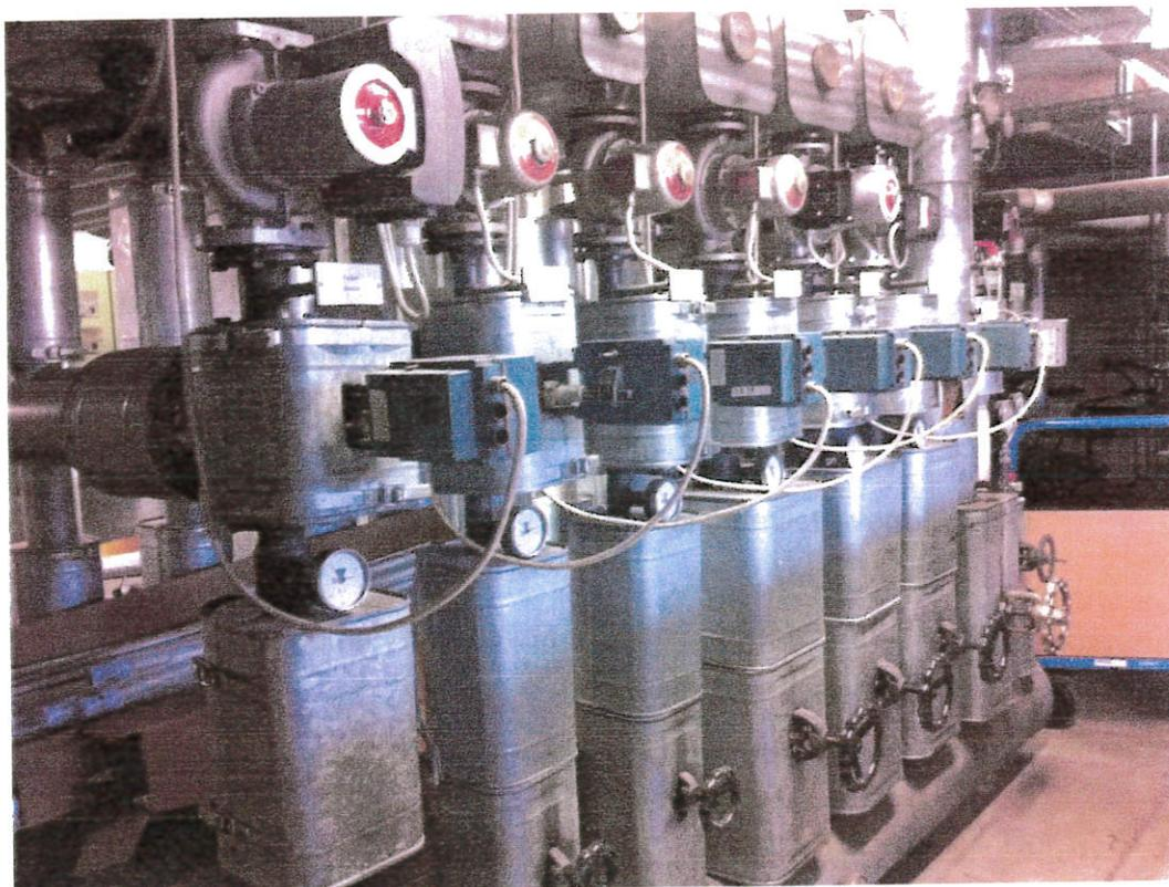
**Abbildung 1-2: Vorlaufverteiler**
