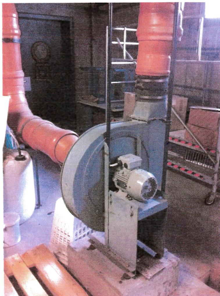
**Abbildung 1-6: Abluftgerät WC alt**
