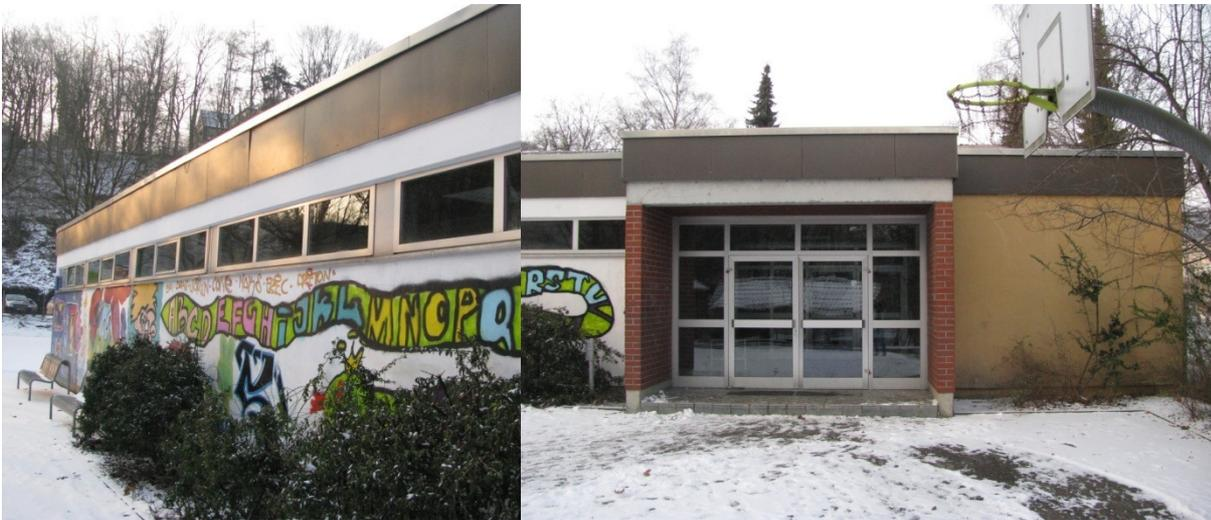
Bei den vorhandenen Fenstern handelt es sich um die Originalfenster von 1977 mit nicht thermisch getrennten Aluminiumrahmen und Zweischeibenisolierverglasung. Die Fenster sind teilweise undicht, die Verglasung innen beschlagen. Der U-Wert dieser Fenster und Eingangstür liegt bei ca. 4,5 W/m<sup>2</sup>K. Rollläden sind keine vorhanden.
