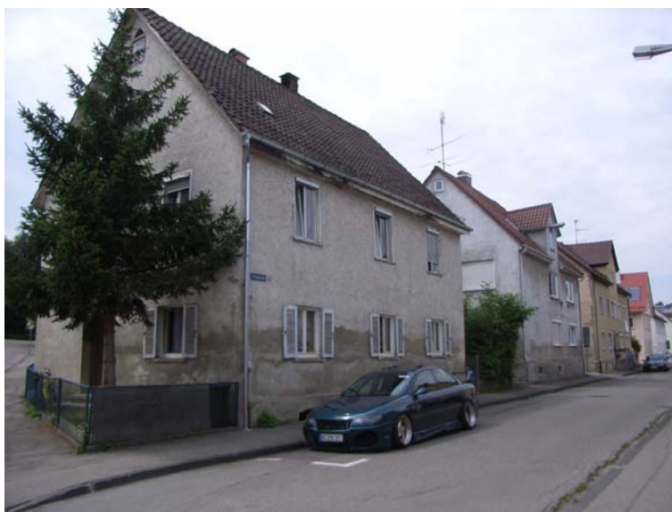
Abbildung 17: Modernisierungsbedürftige Gebäude in der Martinstraße
