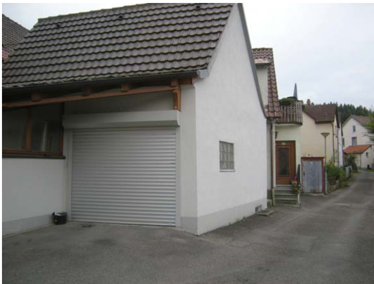
Abbildung 12: Kleinteilige Strukturen im rückwärtigen Bereich der Saulgauer Straße
