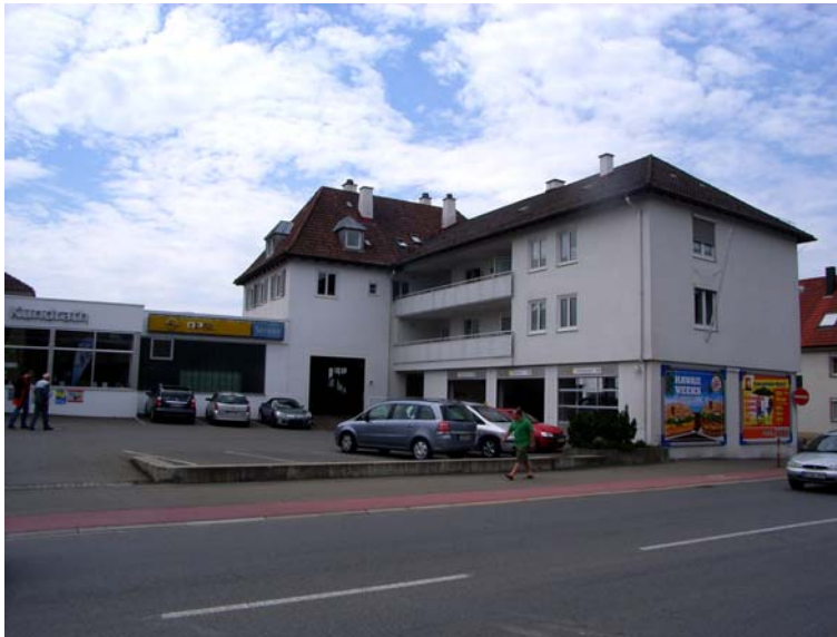
Abbildung 20: Autohaus an der Ecke Saulgauer / Kolpingstraße
