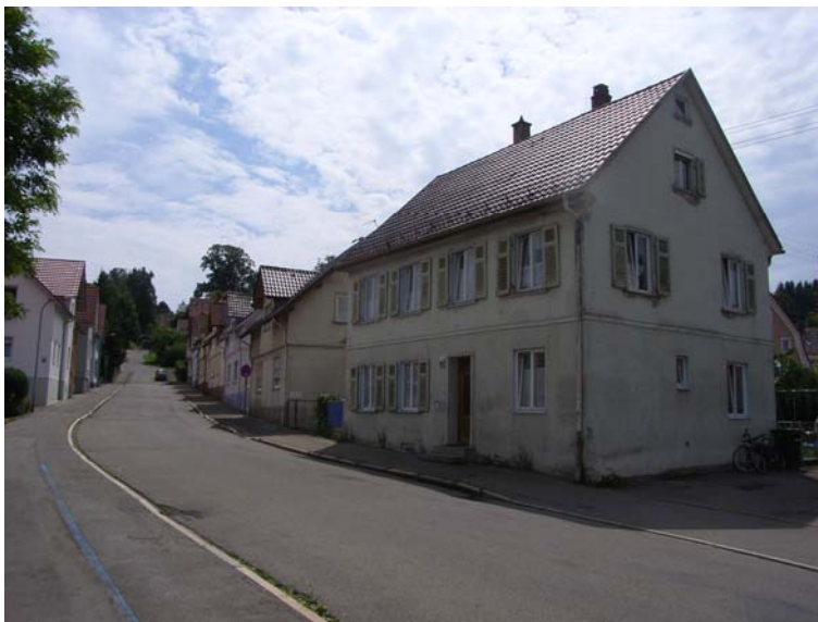
Abbildung 9: Modernisierungsbedürftige Gebäude in der Felsengartenstraße
