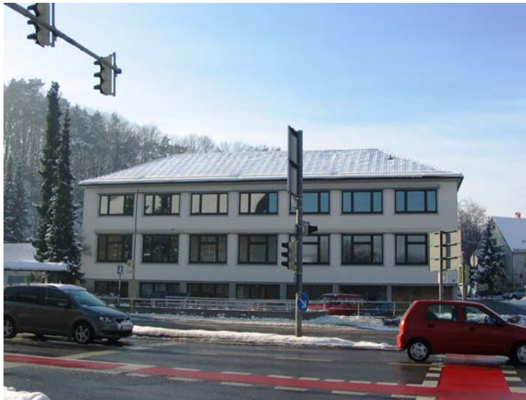
Abbildung 23: Das Gebäude Kolpingstraße 56
