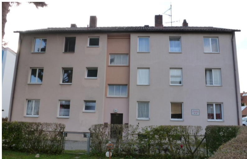
Hans Rohrer Str. 17 Sanierung in 2013
