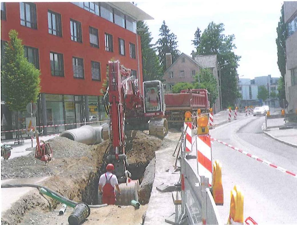
Der Mischwasserkanal im Zeppelinring (Baujahr 1931 und 1932) in einem ersten Bauabschnitt von der Kreuzung Ulmer-Tor-Straße bis zur Einmündung Neherstraße aufgrund der Schadhaftheit der Rohre und einer hydraulischen Überlastung ausgewechselt. Die Maßnahme dauerte vom 10. Mai bis zum 15. Juli 2010 incl. des Straßenbaues.
