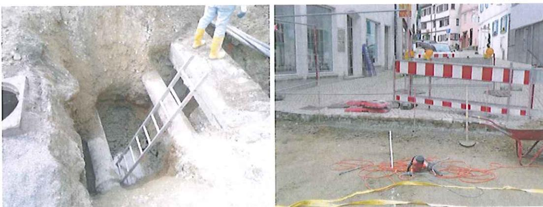
Eine Kanalhaltung auf dem Marktplatz / Engelgasse muss aufgrund der hydraulischen Überlastung und des Kanalalters (Baujahr 1954) erneuert werden. Die Maßnahme wurde im Zuge der Marktplatzsanierung im September 2010 durchgeführt.
