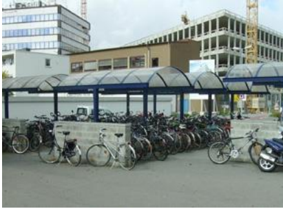
Bahnhofsvorplatz – Abstellanlage von 1995
