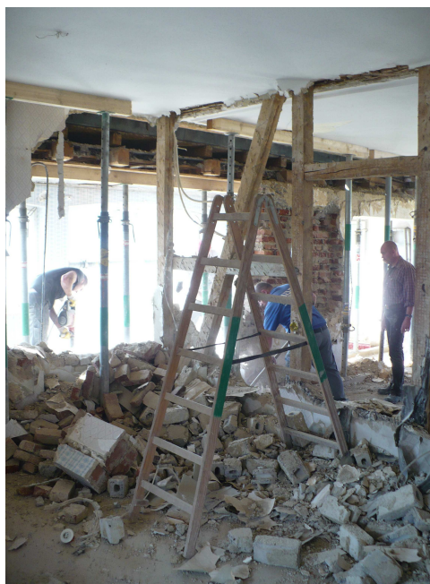
Für eine Optimierung der Wohnungszuschnitte müssen verschiedene Wände weichen.
