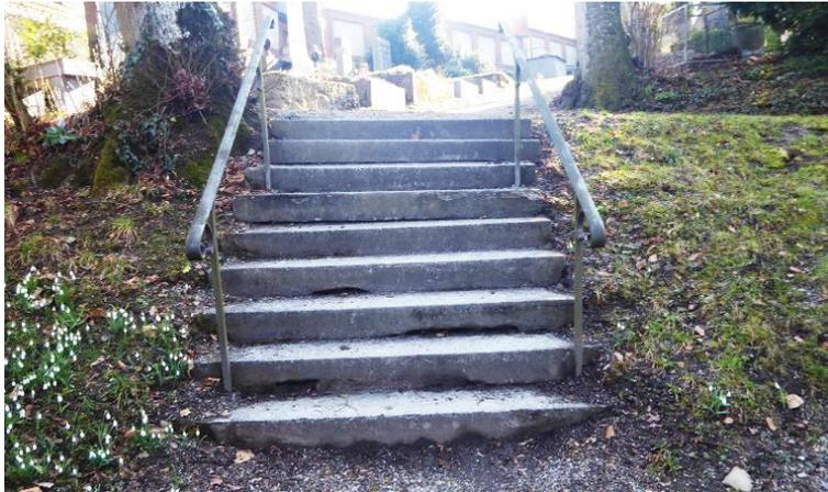
Beschädigte Stufen und Setzungen erschweren das Begehen
